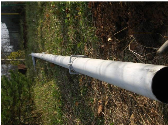
Рисунок 11 Вид хомута для растяжек
