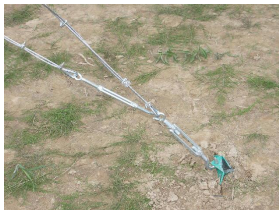
Рисунок 13 Крепление растяжек в 2 яруса
