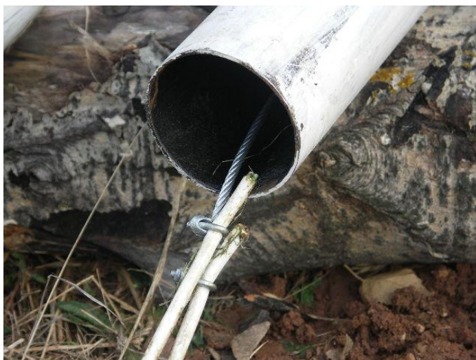
Рисунок 10 Протягивание кабеля через мачту
