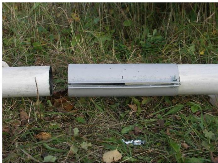
**Рисунок 12 Вид соединительного хомута для труб**
