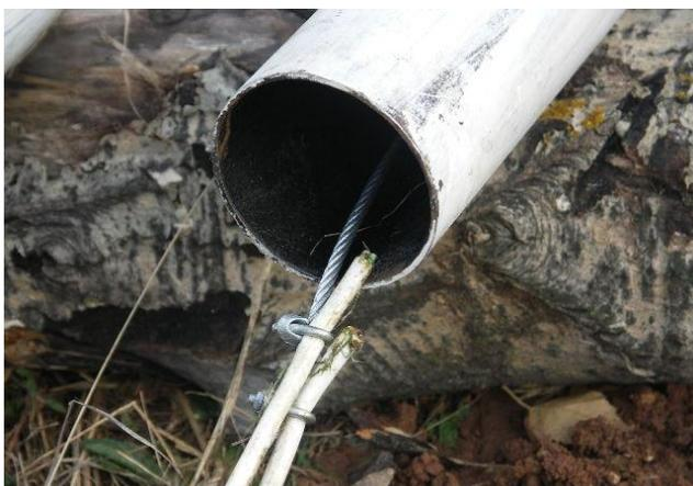
**Рисунок 10 Протягивание кабеля через мачту**
