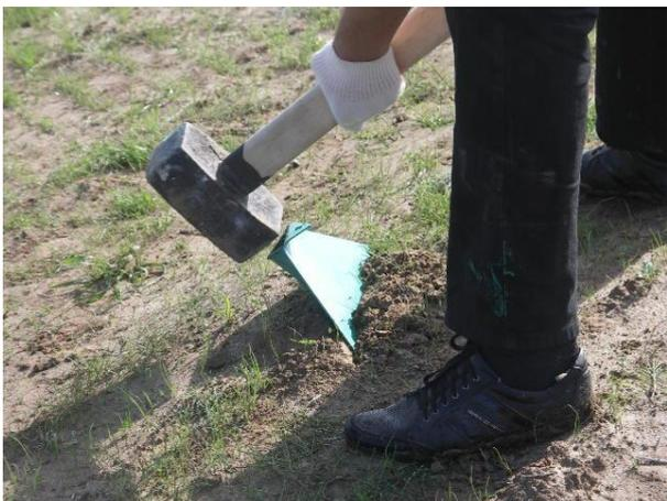
**Рисунок 6 Якорь для растяжки**
