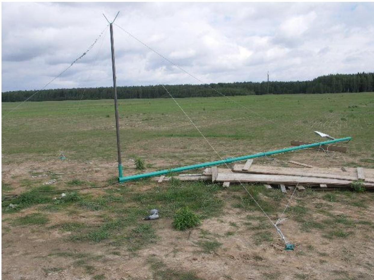
Рисунок 14 Мачта перед подъемом без генератора
