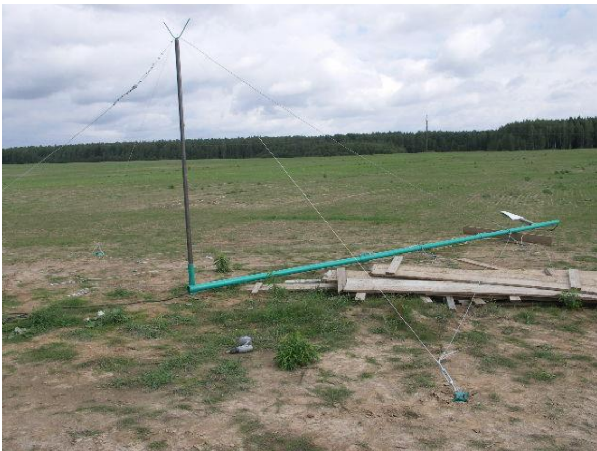
Рисунок 19 Мачта перед подъемом без генератора
