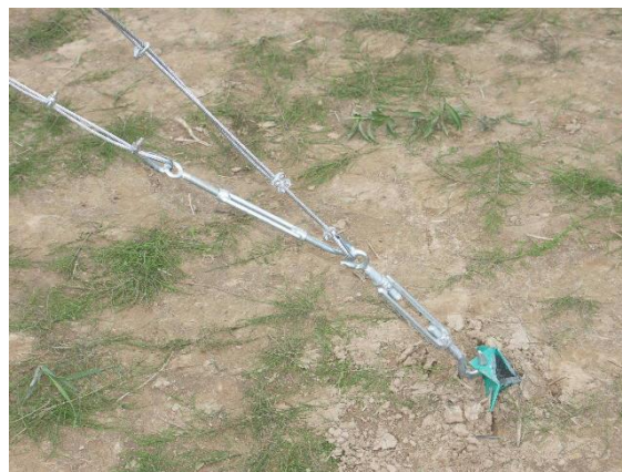
Рисунок 18 Крепление растяжек в 2 яруса
