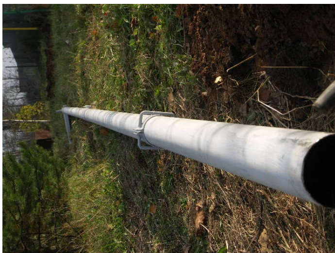
Рисунок 16 Вид хомута для растяжек
