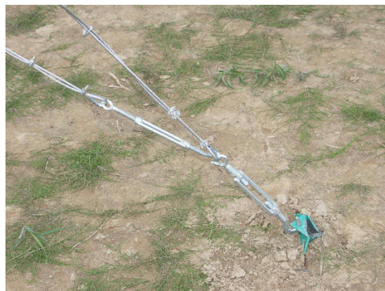
Рисунок 18 Крепление растяжек в 2 яруса
